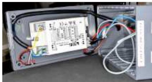
Fig. 27 - b): Alimentatore per tubo fluorescente; interno: si nota il ballast con i relativi collegamenti alla lampada, all'interruttore e alla rete.
